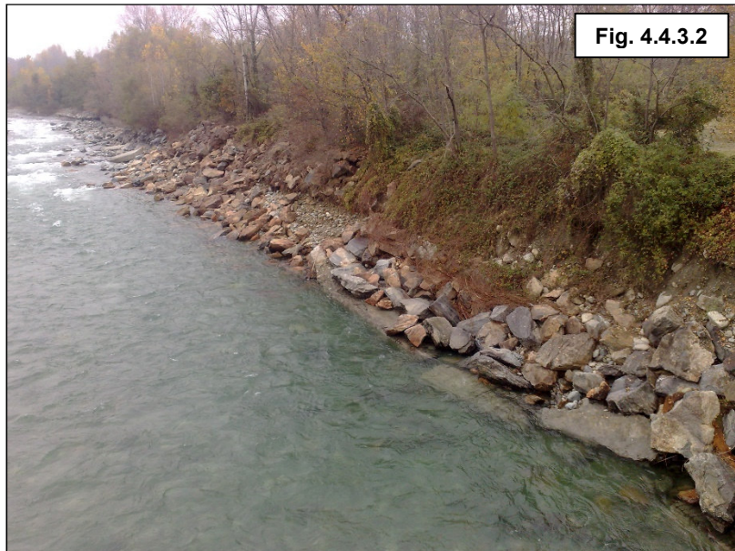
Scogliera distrutta in sponda sinistra (12/11/2011, vista dal ponte verso monte)
