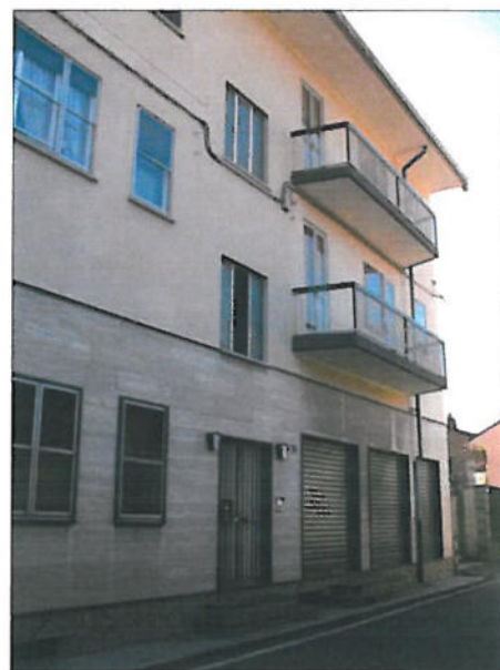
22) fronte Via S. Rocco
