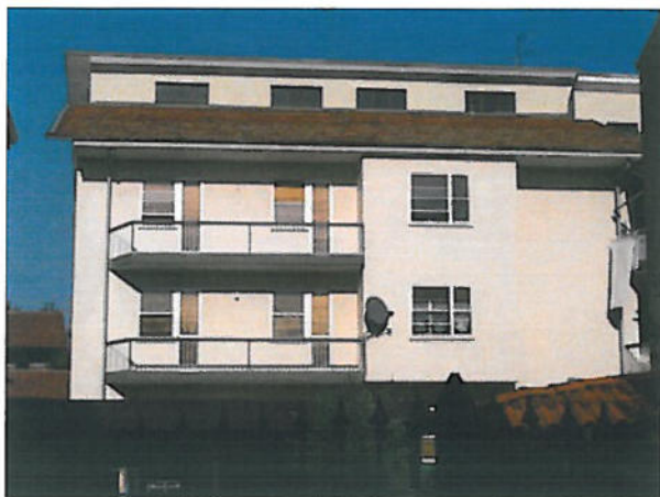
22) vista da corte interna
