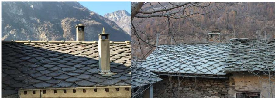
Figura 5: losa a goccia e losa quadrata
