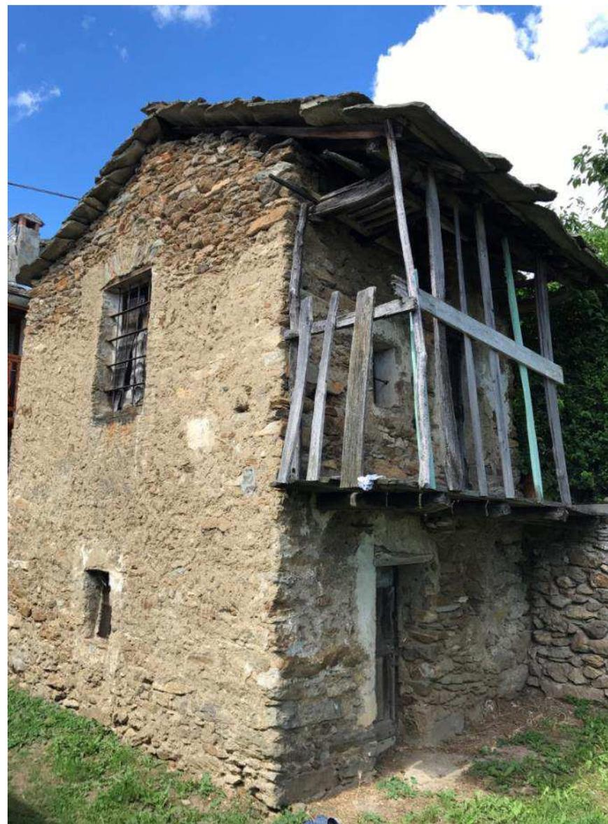
Figura 95: ballatoio con parapetto in listelli verticali
