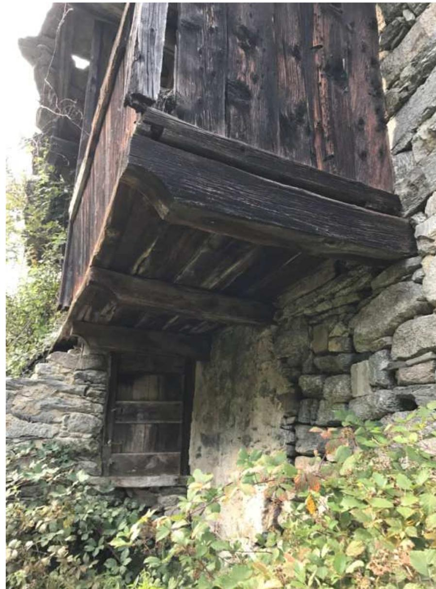
Figura 103: particolare dell'aggancio travi - muratura-ballatoio
