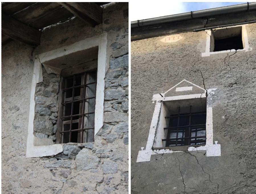
Figura 33: vano in muratura e cornice intonacata
