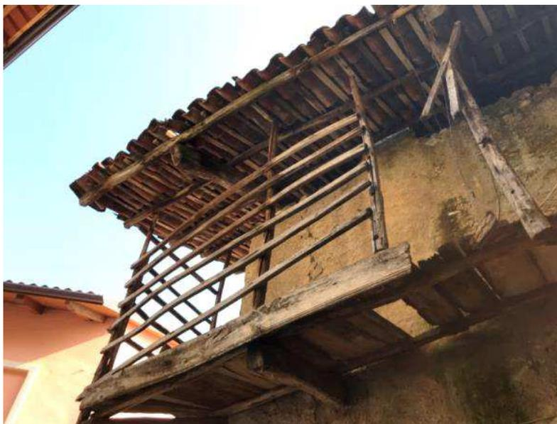
Figura 102: particolare dell'aggancio tetto montanti-ballatoio
