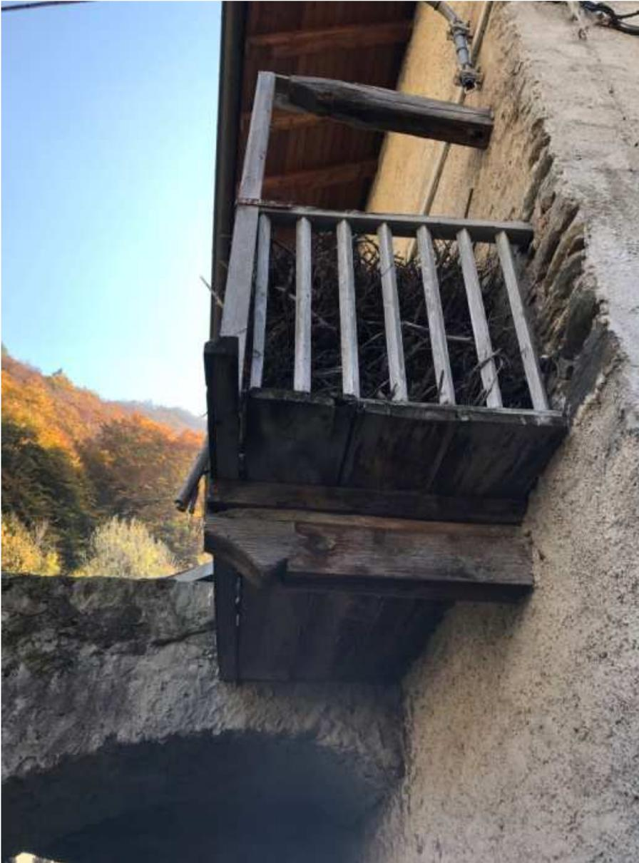
Figura 104: particolare dell'aggancio ballatoio-muratura-travi
