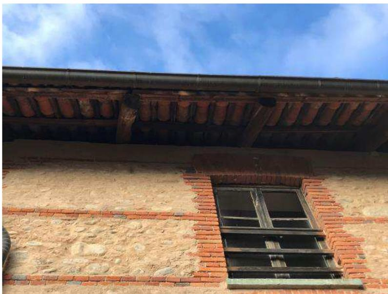
Figura 89: muratura in pietrame con ricorsi in laterizio
