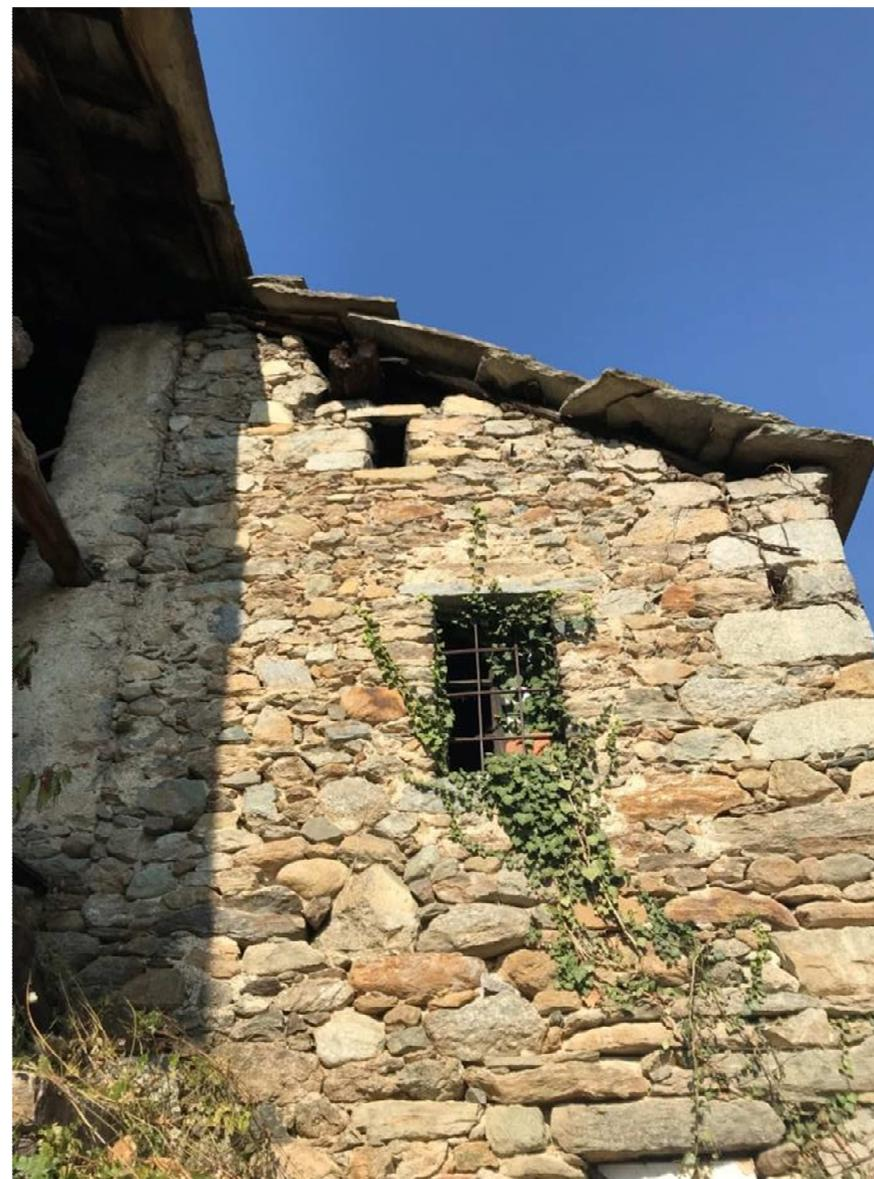
Figura 68: corsi irregolari, posa casuale, collegamento angolare irregolare
