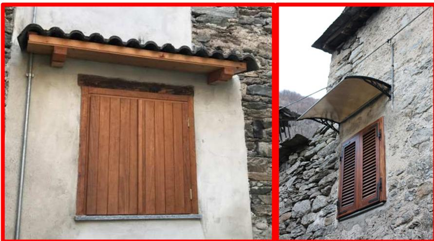
Figura 62 elementi di protezione non conformi alla tradizione costruttiva
