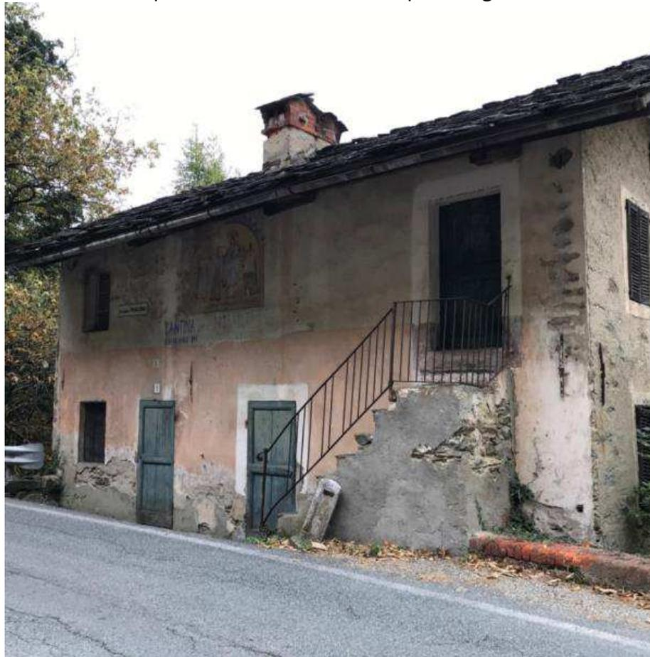
Figura 92: scala in pietra intonacata e ringhiera metallica
