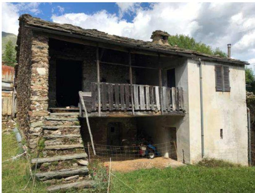
Figura 96: ballatoio con parapetto in tavole di legno rettangolari
