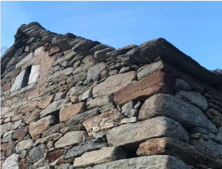
Figura 7: lase poggianti su muro perimetrale Località Alpe Buri –Settimo Vittone
