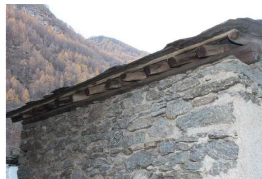
Figura 2: particolare della trave dormiente sul muro perimetrale
