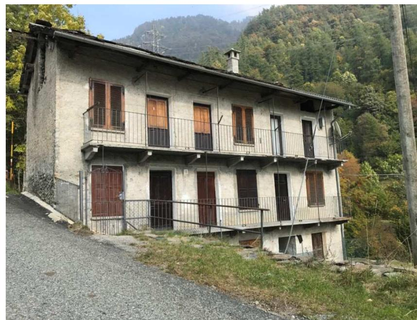
Figura 32: finestre e portefinestre in edifici in linea
