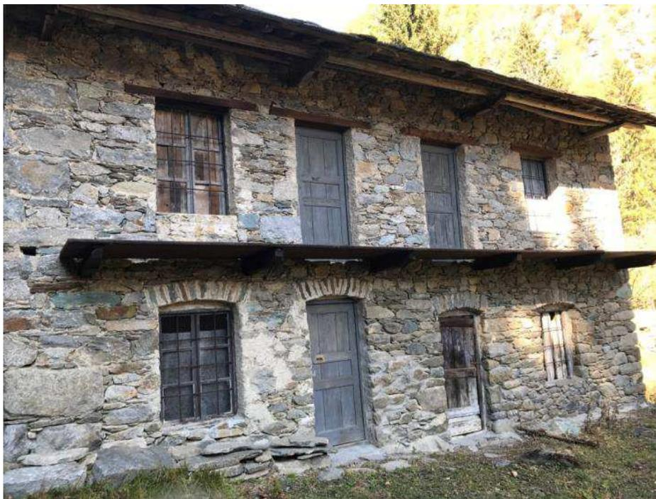
Figura 43: serramenti con architrave ligneo (sopra) e con piattabanda in pietra (sotto)
