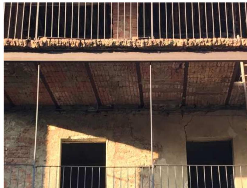
Figura 106 loggiati con solai realizzati con voltini in mattoni e putrelle e montanti in metallo
