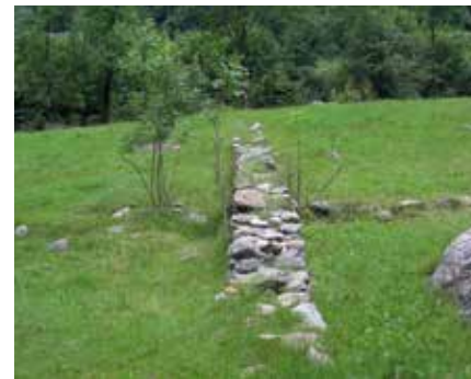
• Muro a secco di delimitazione delle proprietà.
