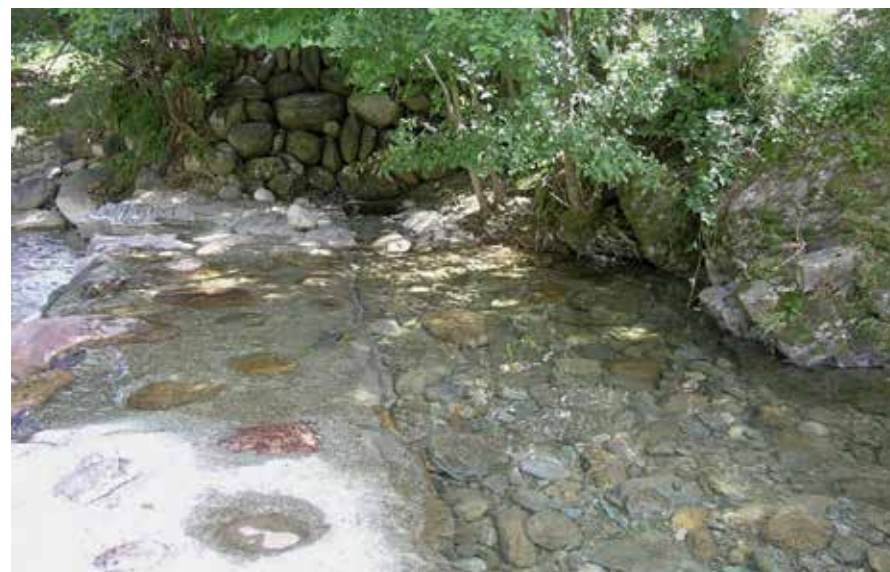
• Particolare traversa di presa.
