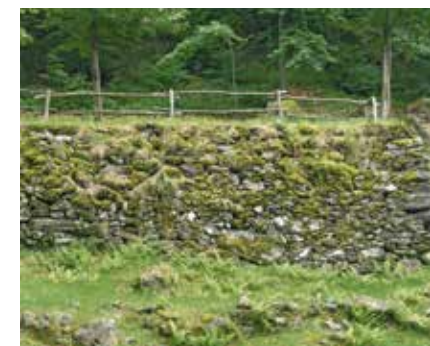
• Muro a secco vegetato.
