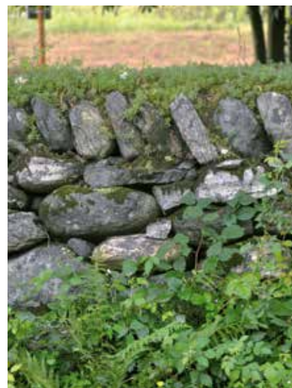
• Particolari di murature da spietramento di pregevole e sapiente fattura.
