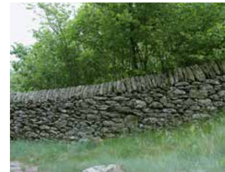
• Coronamento superiore in lastre posate a coltello.
