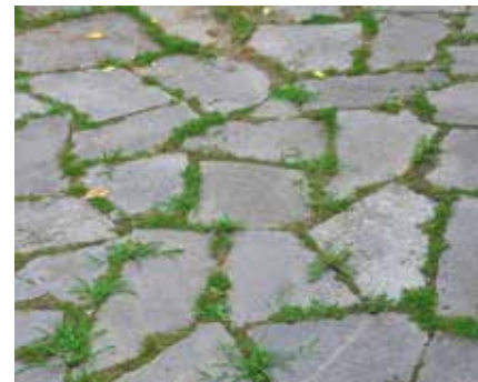
• Pavimentazione in lastricato con giunti inerbiti..
