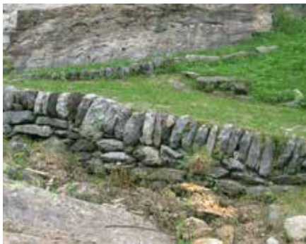
• Muro di contenimento presso un sentiero.
