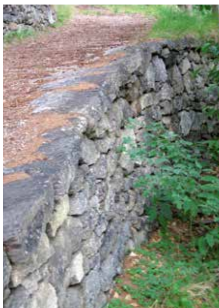
• Muro di sostegno a valle Con coronamento in lastre di pietra posate di piatto.
