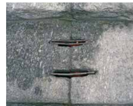
• Particolare caditoia in pietra.
