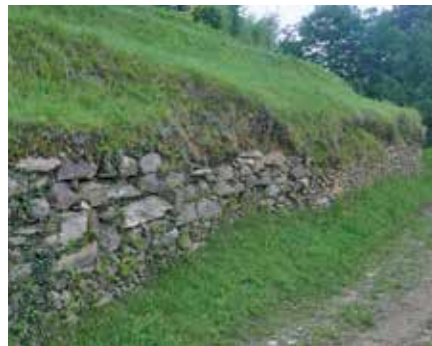
• Muro di sostegno di scarpata.
